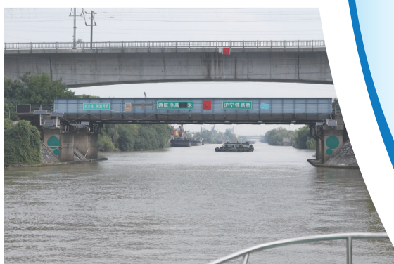
桥梁低矮限制大型船舶通行 储诚 摄
