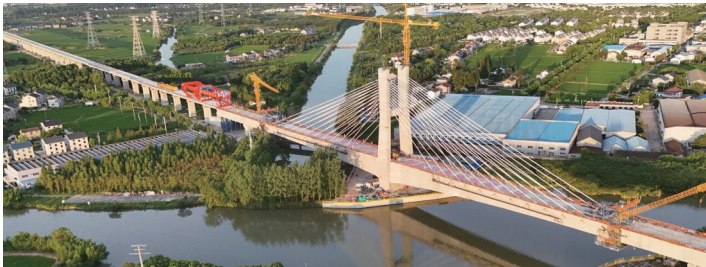
通苏嘉甬高铁全线控制性工程跨张家港河斜拉桥精准合龙 苏州市交通运输局供图
