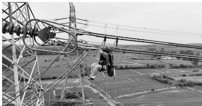
电网工作人员在高空作业 通讯员供图
