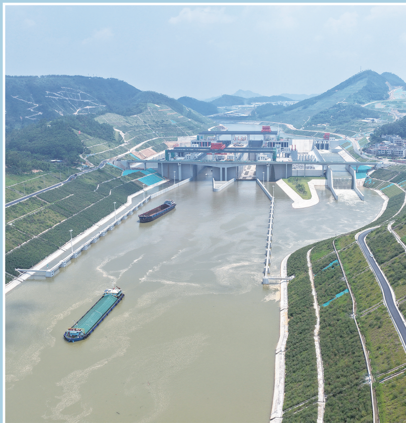
8月12日，试验船舶通过平陆运河马道枢纽船闸（无人机照片） 新华社发
