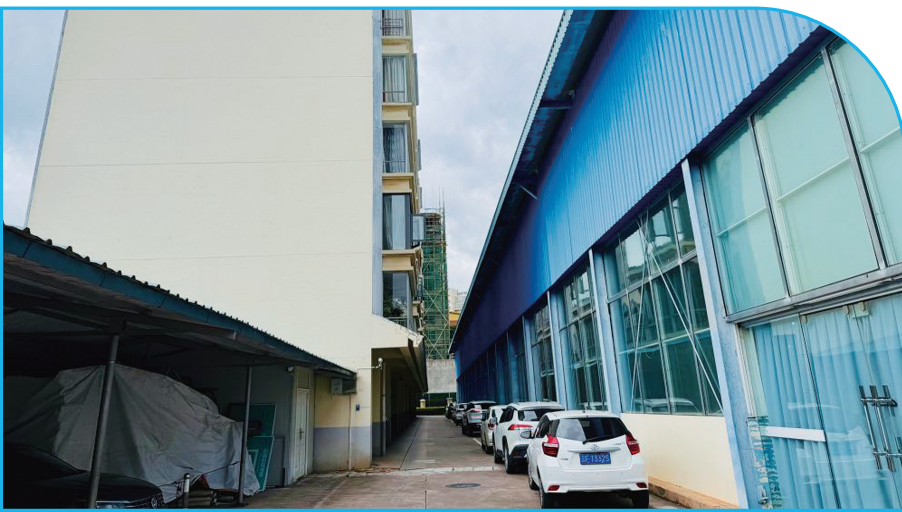
云南玉溪平福园小区内的室内运动场馆，墙体全面铺设吸音棉，靠小区一侧全部更换成双层中空隔音玻璃 新华社记者 熊轩昂 摄
