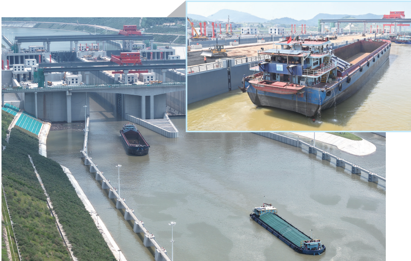
小图:试验船舶驶进平陆运河马道枢纽船闸 大图:试验船舶驶出(无人机照片)
