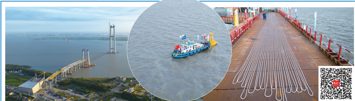
一根直径21毫米的轻质高强迪尼玛绳，经船舶牵引平稳跨越2300米江面，与北岸精准对接 省交建局供图 扫码看视频
