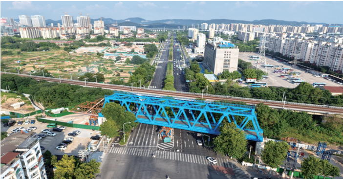
秦淮河特大桥跨石杨路80米钢桁梁顶推施工顺利完成 图片来源:南京建设公众号
