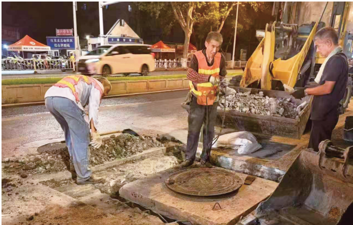
施工人员正在整治道路窨井 通讯员供图
