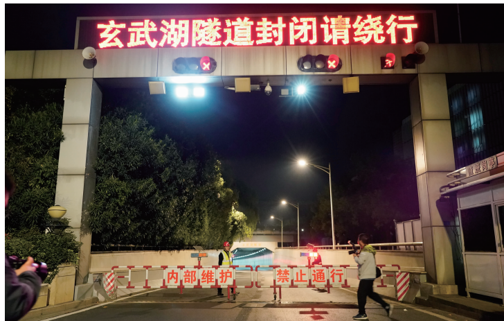
玄武湖隧道夜间封闭
