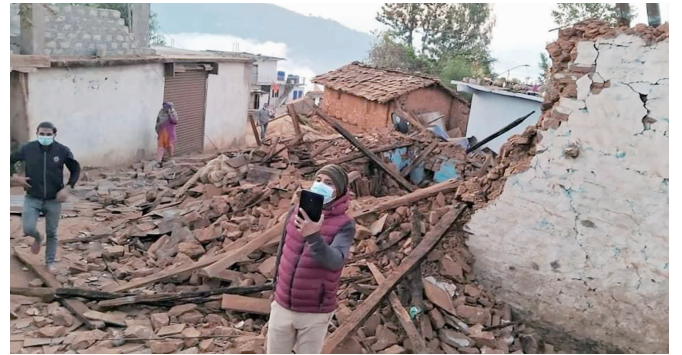
11月4日在尼泊尔西部扎泽尔果德拍摄的被地震损毁的房屋 新华社发
