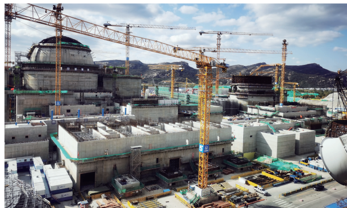
建设中的7、8号机组
