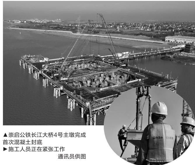
▲崇启公铁长江大桥4号主墩完成首次混凝土封底
