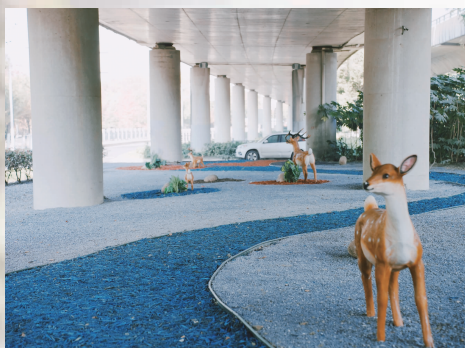
长江东路上跨机场南路桥下空间
