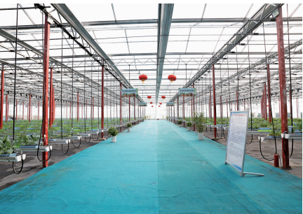
泰兴市滨江镇现代农业科技产业园智能高效玻璃温室大棚 本版由通讯员供图
