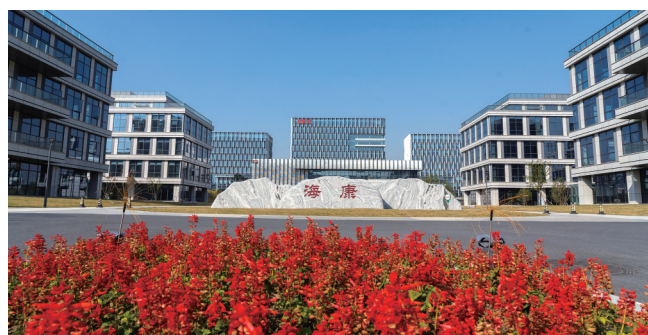
中电海康无锡物联网产业基地 本版图片均由无锡高新区太湖湾科创城提供
