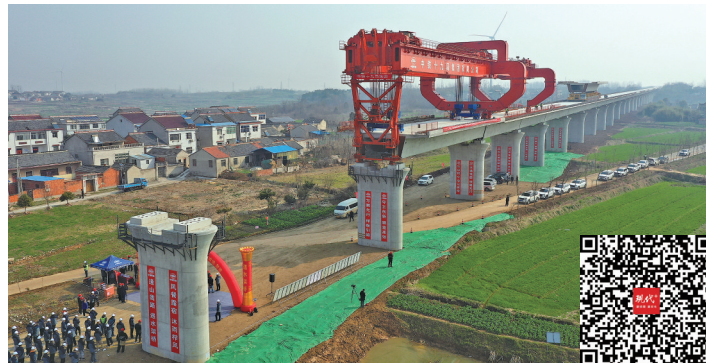
北沿江高铁南京段开始架梁
