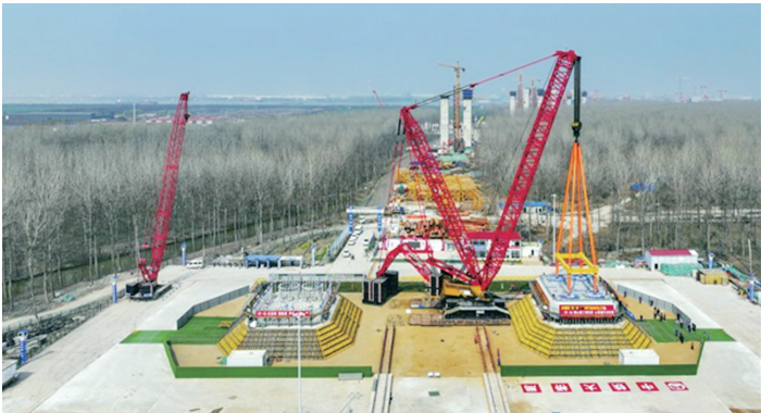
张靖皋长江大桥南航道桥北主塔
