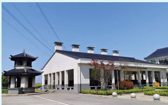
锡北镇八士安息堂内的集中祭祀区与集中焚烧炉
