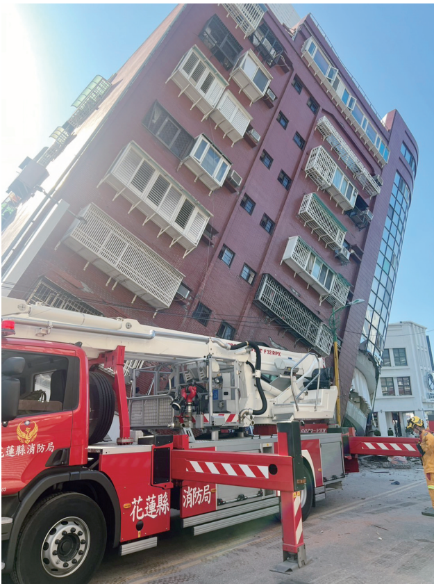
强震发生时，花莲县北滨街一栋公寓民宅大幅度倾斜 新华社发
