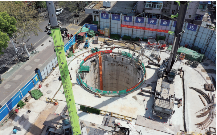
南湖中心广场沉井式停车场施工现场
