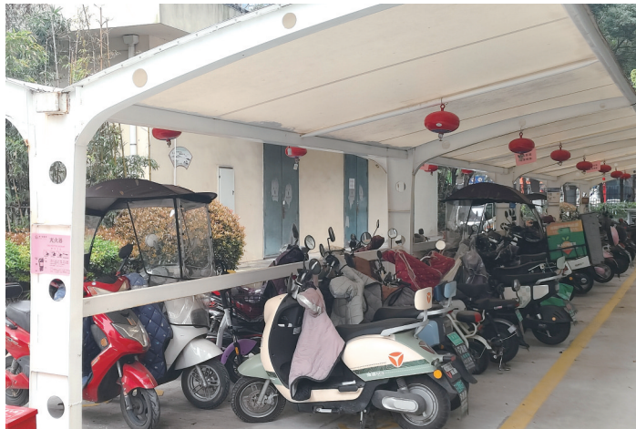
香滨湖小区充电棚顶配了灭火装置 消防供图
