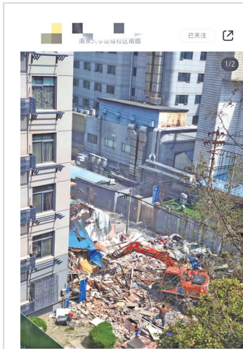
网友拍摄的施工路段俯瞰图
