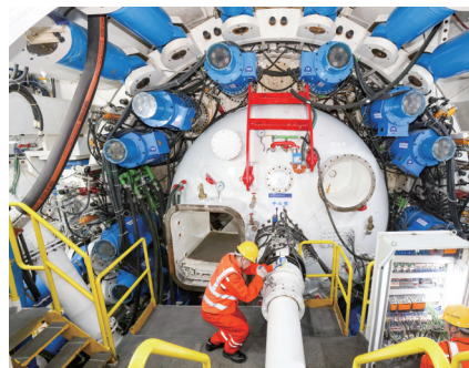
苏州东隧道开始盾构掘进
