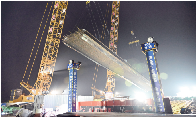
高铁海门北站最后一幅地连墙钢筋笼顺利入槽并完成浇筑 通讯员供图
