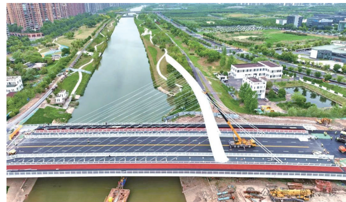
镇南河路跨七里河桥梁工程已完工 图片据南京建设公众号
