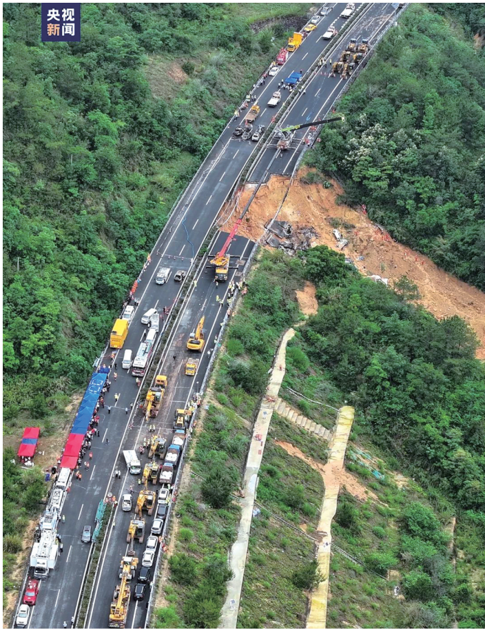
广东梅大高速塌陷现场 央视截图
