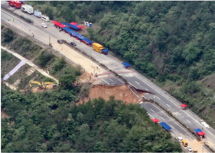
航拍事故现场，救援仍在进行 现代快报/现代+记者 顾炜 摄
