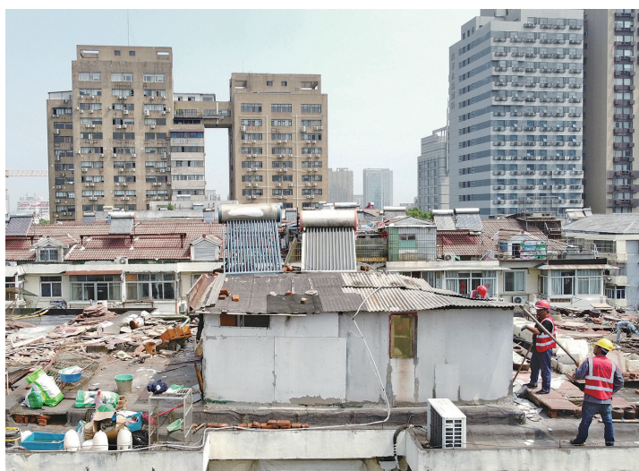
违建拆除作业正在进行
