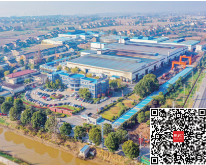
江苏亚星锚链股份有限公司;锚链生产现场
