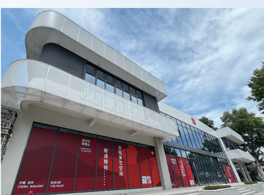
改造后：前线大院沿街店铺
