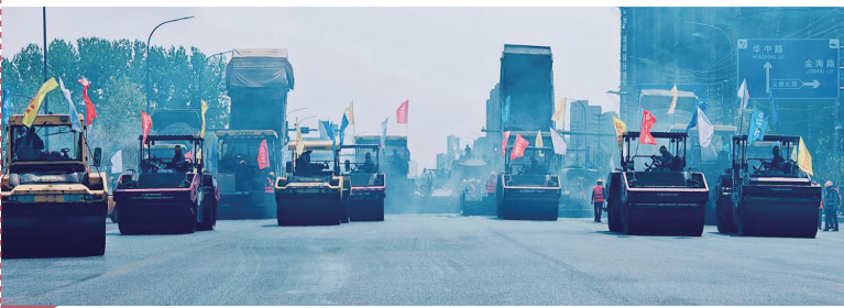
市政道路改造提升施工现场 通讯员供图
