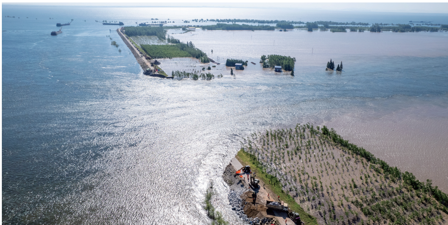
这是7月6日在湖南省岳阳市华容县团洲垸拍摄的洞庭湖大堤决口现场(无人机照片) 新华社记者 陈思汗 摄
