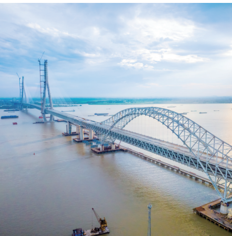
正在建设中的常泰长江大桥
