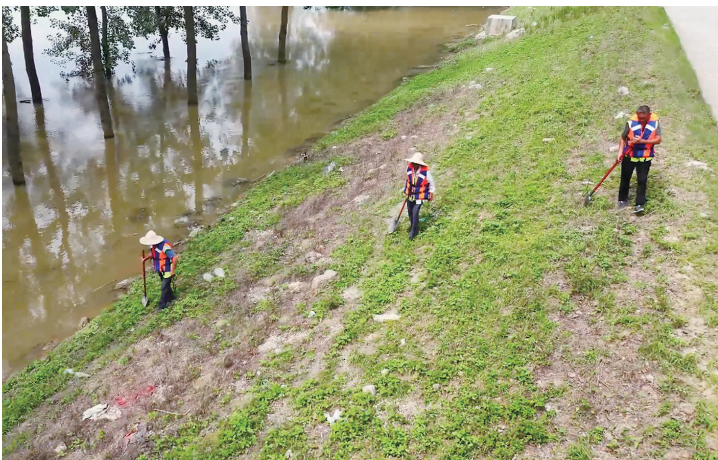
巡堤人沿堤巡查
