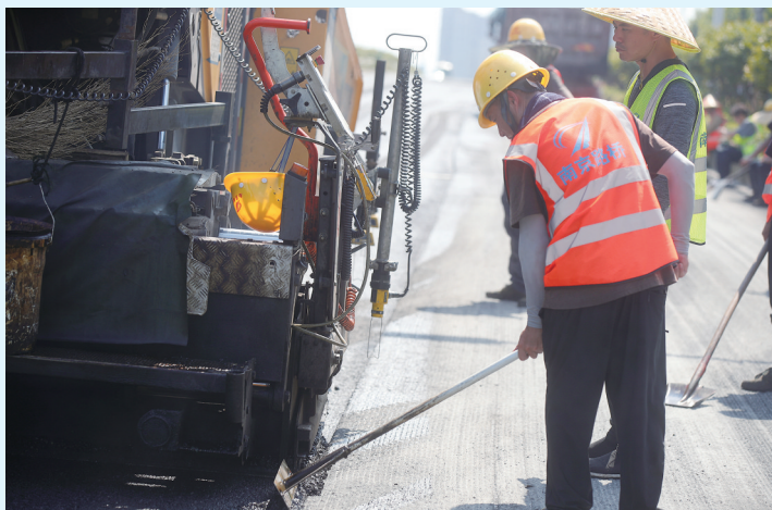
122省道宁张线(南京至张家港)的路面养护工程施工现场,工人们战高温加紧施工
