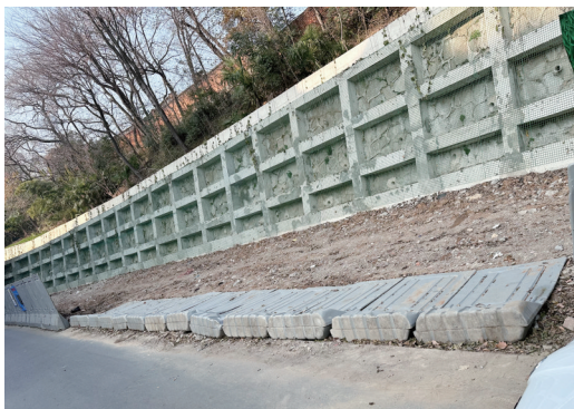
安装充电桩之前,这里是一片空地
