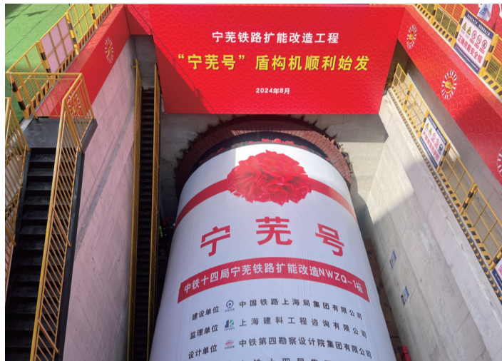
宁芜铁路扩能改造工程“宁芜号”盾构机始发 现代快报/现代+记者 刘伟娟 摄
