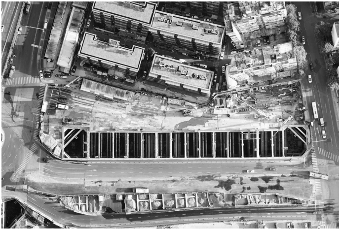
四平路广场站主体结构最后一块底板完成浇筑 图据南京地铁
