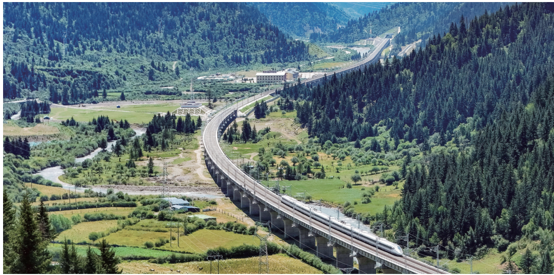
一列试运行列车行进在黄胜关站至黄龙九寨站间(8月29日摄，无人机照片) 新华社记者 江宏景 摄
