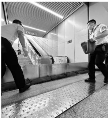
地铁工作人员堆沙包、组装防淹挡板以应对恶劣天气 苏州市交通运输局供图
