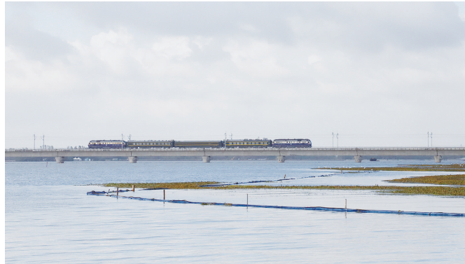
首趟检测列车驶过沪苏湖高铁曹浦特大桥示范段 罗零佳 摄
