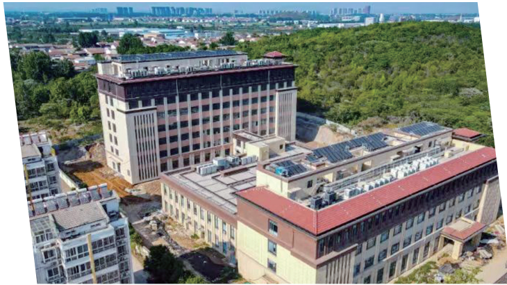
经开区东山老年康复护理院已顺利竣工 徐州经济技术开发区宣传部供图
