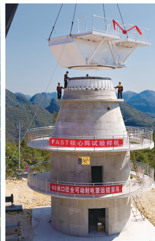
9月25日，首台核心阵试验样机在吊装中(无人机照片) 新华社发
