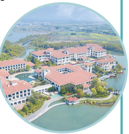
金坛合成生物产业园航拍
