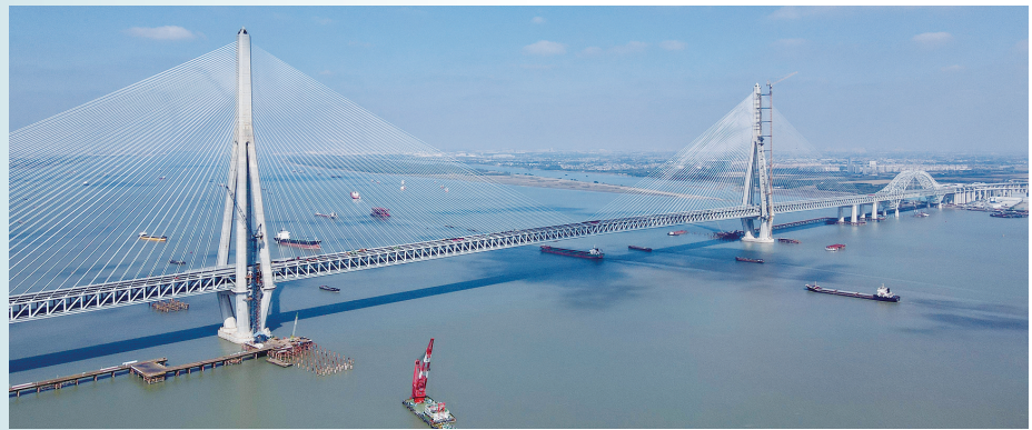
建设中的常泰长江大桥
