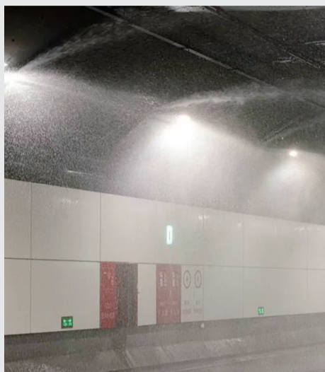
智慧消防系统的喷水效果测试
