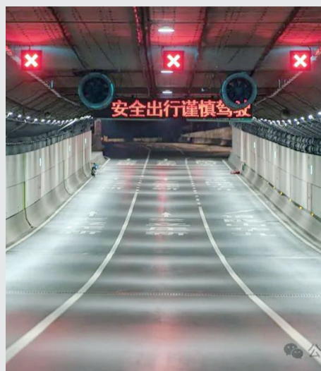
玄武湖隧道即将完成首次“大修”
