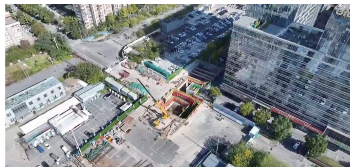
南京南隧道施工现场 中铁十四局供图
