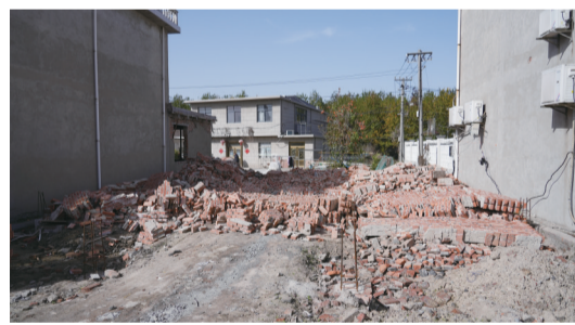
11月27日,违建房屋已拆除 现代快报/现代+记者 顾潇
