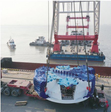
刀盘中心块在海门中远重工码头吊装上岸 通讯员供图
