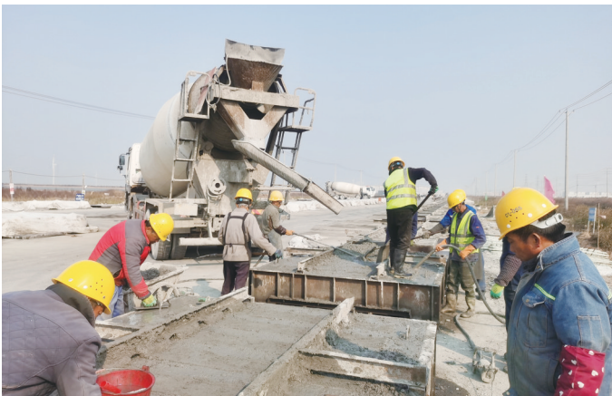
混凝土构建预制现场，工人们正在忙碌 通讯员供图
